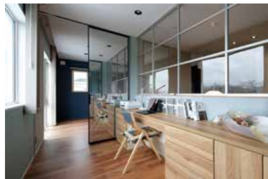
壁面には樹脂製の室内窓を取り付けました。建具は鏡面になっており、小さな部屋でも狭さを全く感じません。
